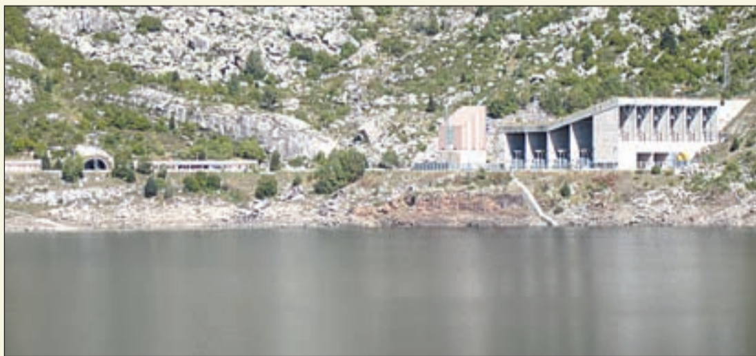
FOTO: F.G. / Imatge de la presa i central (al fons) de Sallente, ubicada a la Vall Fosca als peus del telefèric
