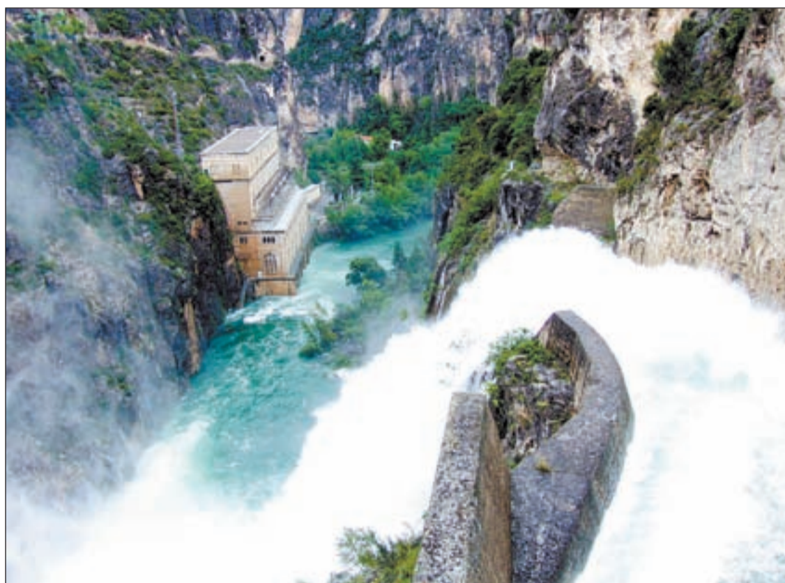
FOTO: Endesa / La de Camarasa (a la imatge) és una de les centrals històriques de la demarcació de Lleida
