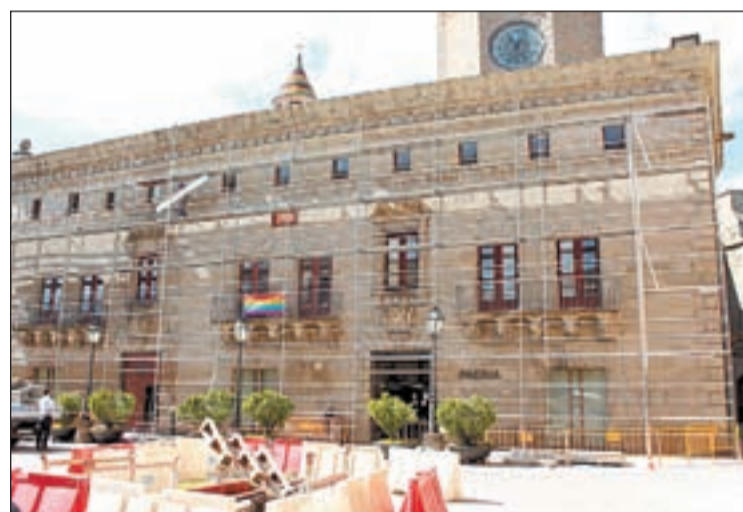
FOTO: / Ja han instal·lat la bastida a la façana principal de la Paeria
