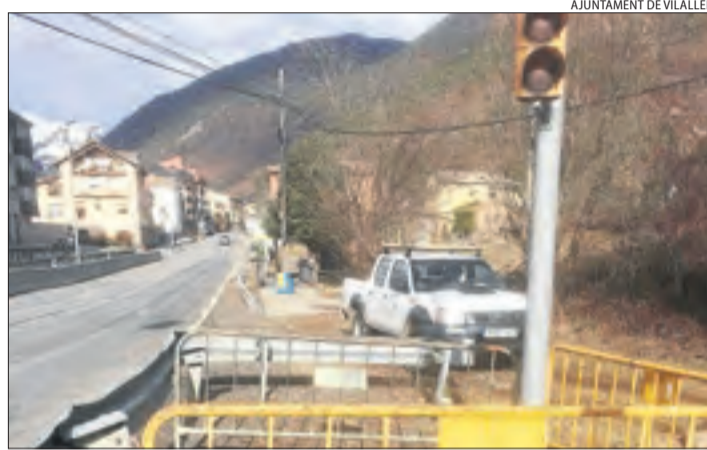
Instal·lació d'un semàfor a la travessia de l'N-230 a Vilaller.
