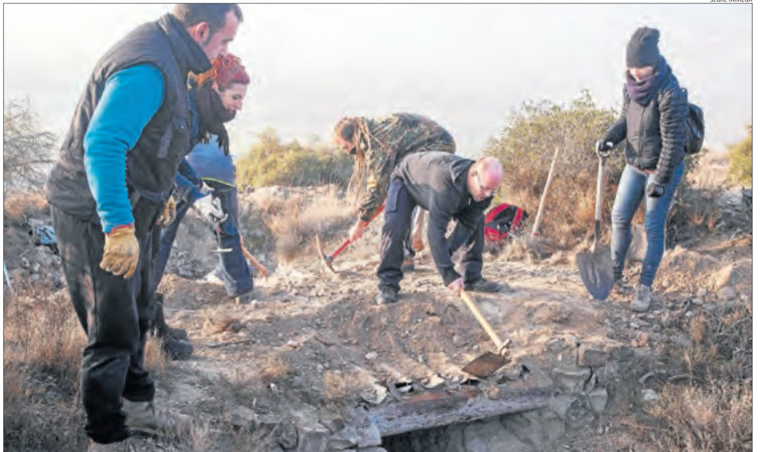
Diversos voluntaris van reparar la coberta d'una fossa, que havia quedat danyada per l'actuació dels vandals al desembre.
