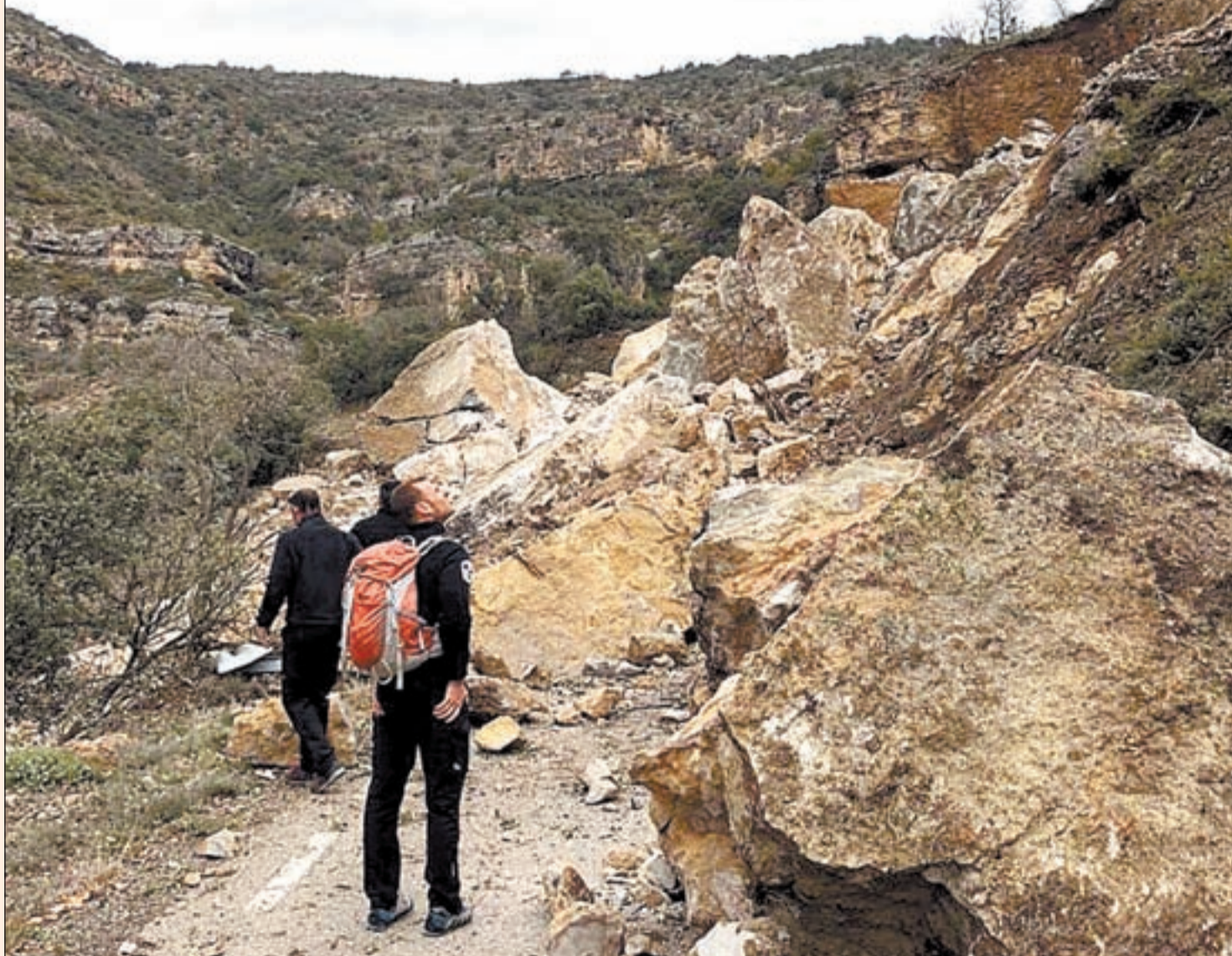
FOTO: Mossos d'Esquadra / El desprendimiento se produjo ayer en la LV-9124 a su paso por la localidad de Castell de Mur
