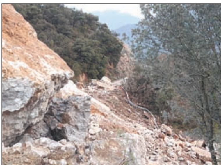
FOTO: Tony Alcántara / Estat en el que va quedar la via pel despreniment
