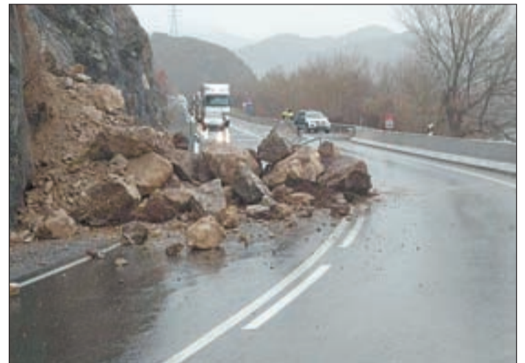
FOTO: / El darrer despreniment a la N-230 a la zona d'Escales
