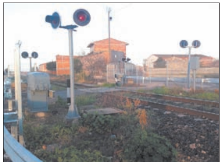
FOTO: FGC/ Lloc on s'ha eliminat el pas a nivell a Vilanova de la Barca
