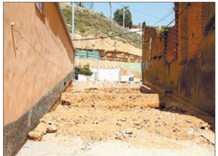
FOTO: Jordi Pascual / Obres de la nova escalinata al carrer Orient
