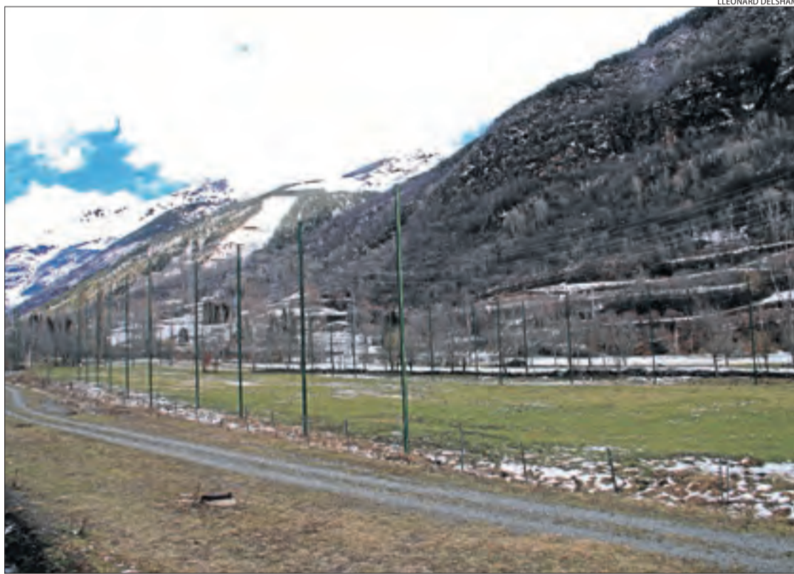
Els terrenys del camp de golf, construït fa una dècada i que mai va arribar a funcionar.
