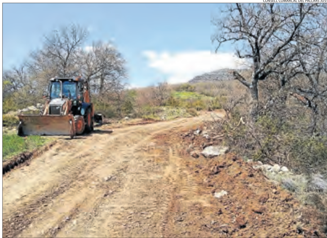
Imatge dels treballs d'ampliació del camí rural des d'Estorm fins a Cellers.
