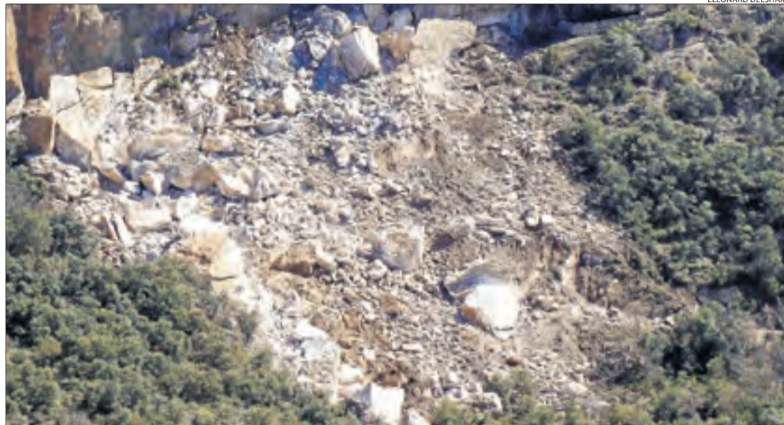
Imatge del desprendiment de roques sobre l'LV-9124 a Castell de Mur.
