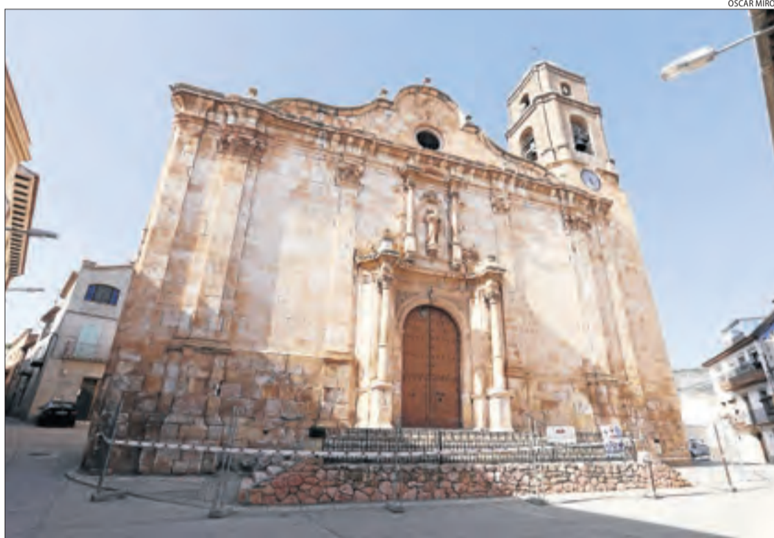
Les tanques que s'han instal·lat a l'església d'Algerri al detectar desprendiments a la façana.
