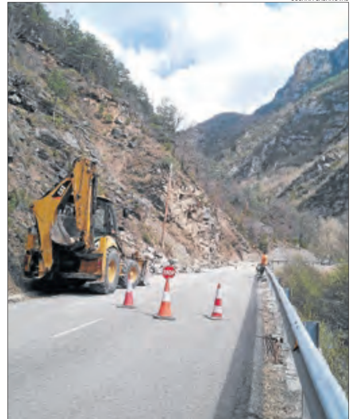
Operaris treballant a la carretera N-260 ahir a la tarda.
