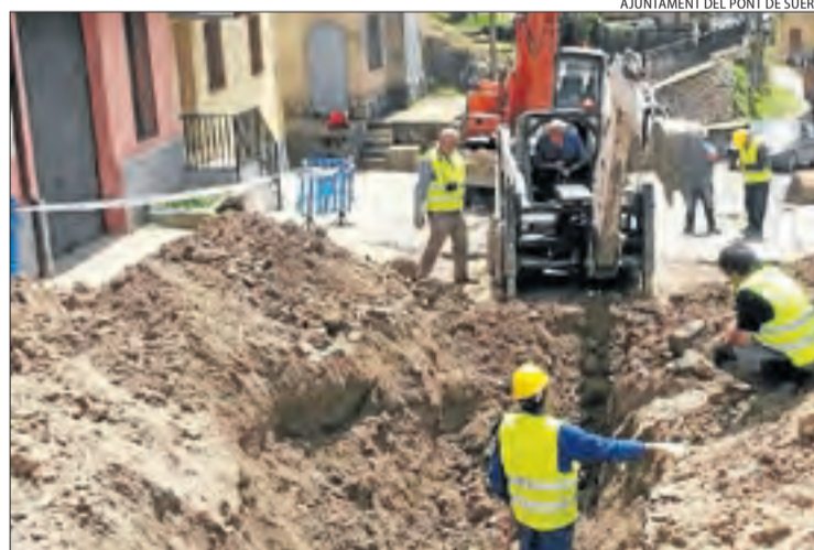
Els operaris van iniciar els treballs d'emergència.
