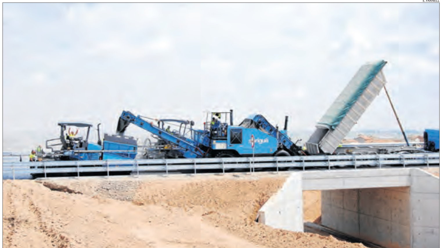
Els operaris van aplicar ahir l'última capa d'asfalt a la ronda, que podrà estar a punt d'aquí a dos setmanes.
