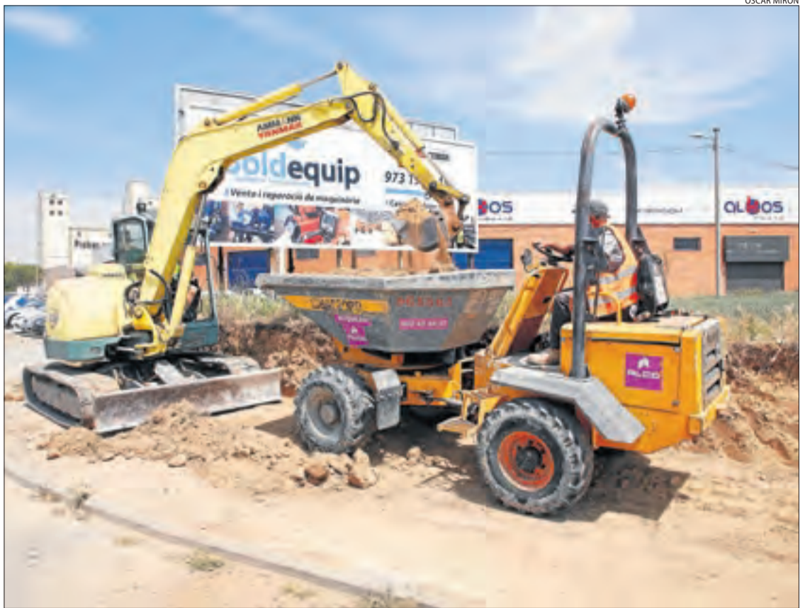
Les obres al carrer Democràcia d'Alcoletge per a la via ciclista entre Lleida i Girona.
