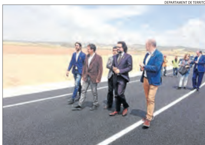
Visita d'obres ahir a la nova variant de Balaguer.
