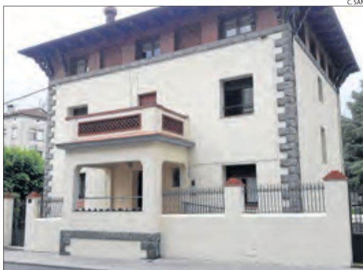
Vista del centre residencial al carrer Llorenç Tormàs i Costa.
