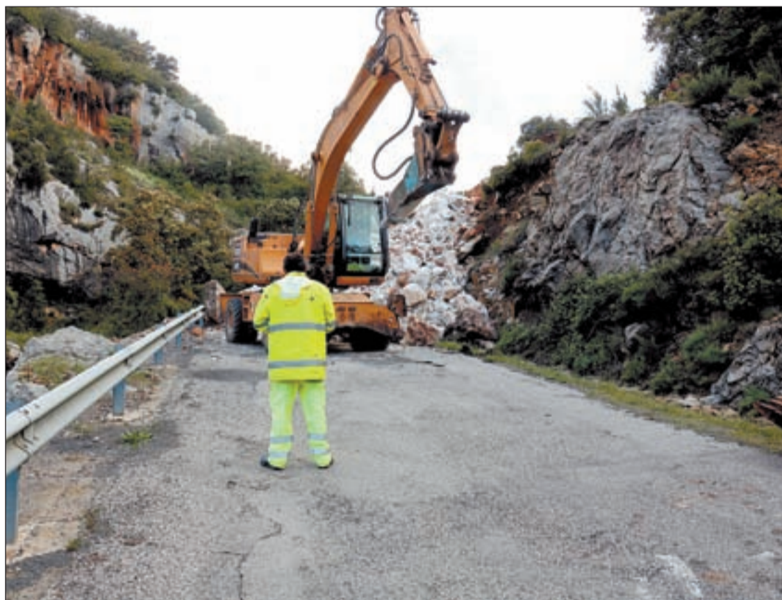
FOTO: Oriol Bosch (ACN) / Una màquina i un operari esmicolant la roca de grans dimensions de la carretera
