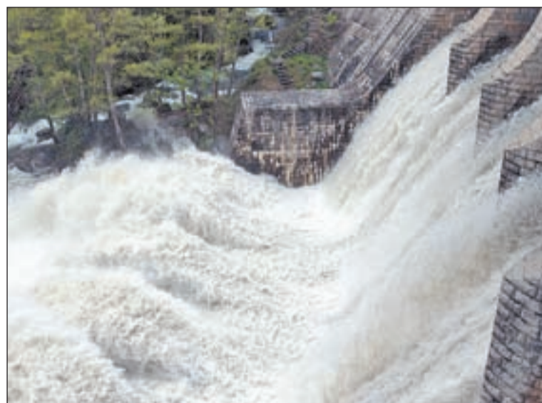
FOTO: R.Baylina / La presa de la Torrassa, desembassant
