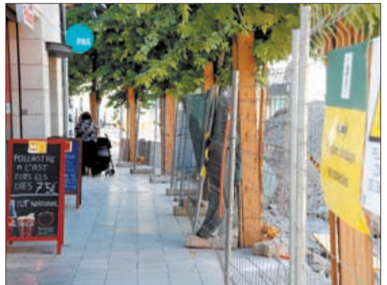
FOTO: ACN / Obres a la plaça de Manuel Bertrand i comerços al costat
