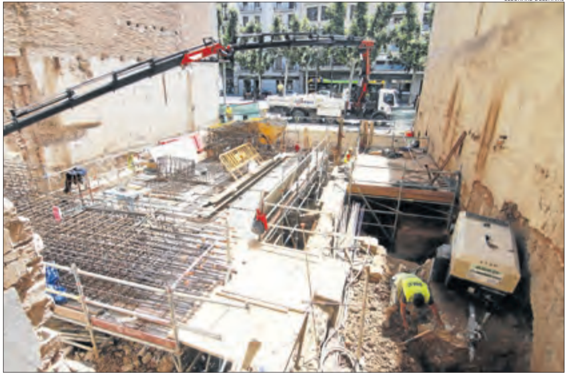
Imatge de les obres de construcció del nou edifici de la Diputació a la rambla Ferran.
