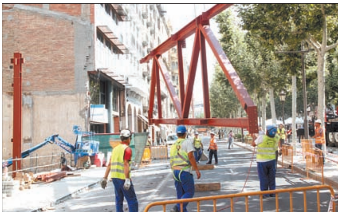
FOTO: Tony Alcántara/ Una estructura de grans dimensions va ser instal·lada durant el matí d'ahir
