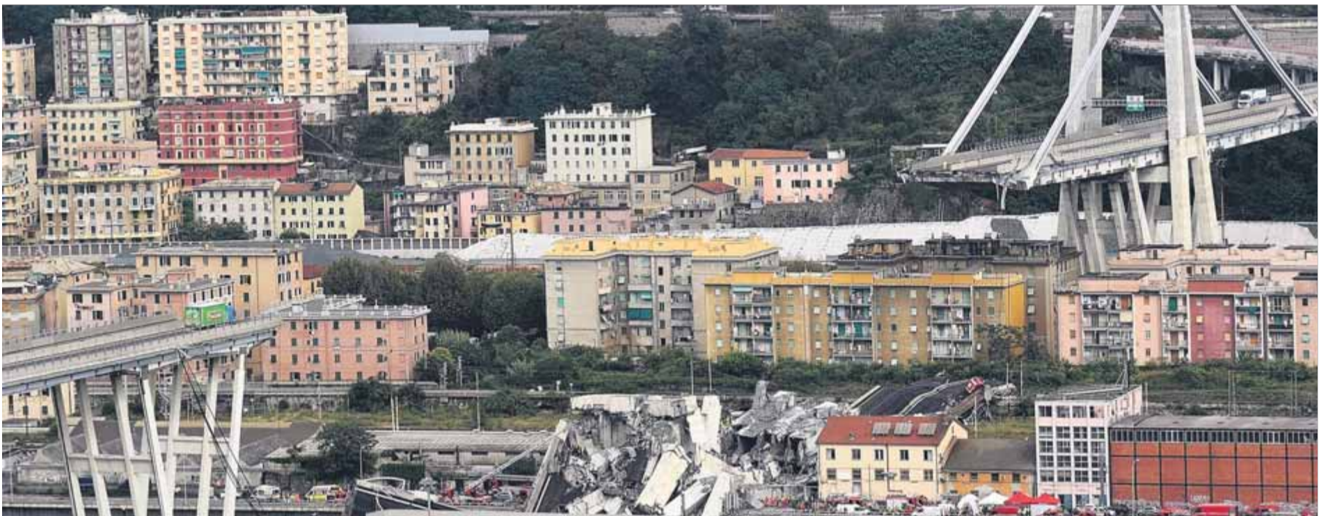
El viaducte es va ensorrar en un tram d'uns 100 metres de llarg. Un camió d'una cadena de supermercats, de color verd, va evitar en l'últim instant la tragèdia ■ EFE/FLAVIO LO SCALZO
