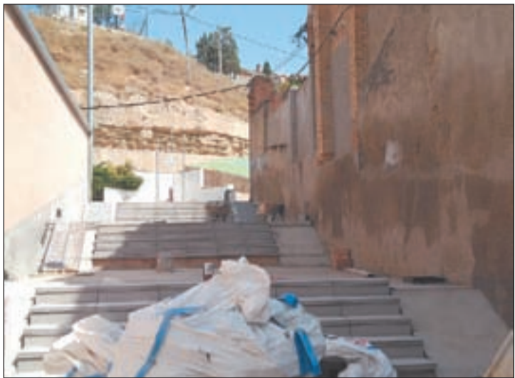
FOTO: Aj. Almacelles / Les obres de condicionament del carrer
