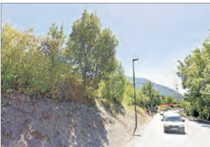
El tram de l'N-230 al Pont on es construirà una vorera.
