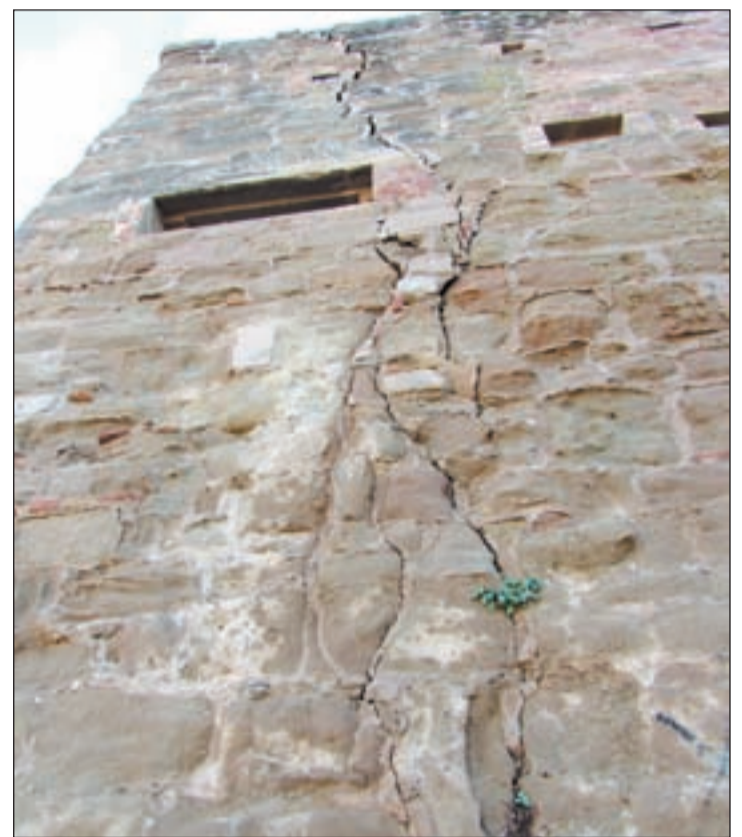
FOTO: Iago Aránega / La grieta recorre todo el muro
