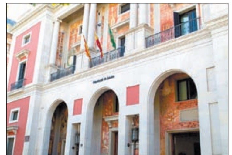
FOTO: Diputació / Façana de l'edifici de la Diputació de Lleida
