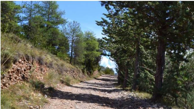
Exemple de camí forestal del Pallars Jussà amb les branques dels arbres del marge envaint el gàlib del vial.
