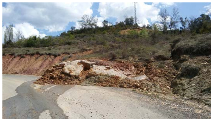
Figura 41. Esllavissades de flux durant l'abril de 2018 en vessants argiloses que no van poder resistir el pes del terreny saturat d'aigua. Esquerra: Sant Esteve de la Sarga. Dreta: Alsamora, enduent-se per davant un mur d'escollera. Municipi de Sant Esteve de la Sarga. Font: Jordi Castilló
