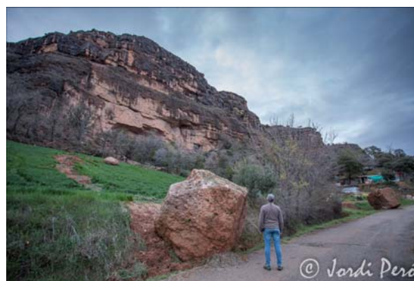
Figura 39. Caiguda de blocs rocosos a tocar de Gurp , municipi de Tremp, el 5 d'abril de 2016. Font: Jordi Peró
