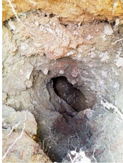
Figura 45. Fenomens de subsidiència a les antigues mines de carbó de Sossís (Conca de Dalt). Esvoranc aparegut l'abril de 2018 al sostre d'una antiga galeria. En anys anteriors han aparegut altres evorancs a la mateixa zona, molt més grans que aquest.
