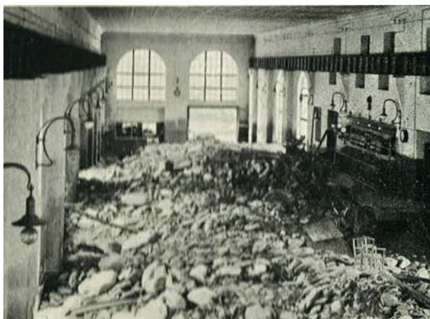
Figura 22. Sala de màquines de la central hidroelèctrica de Capdella després dels aiguats de l'octubre de 1937
