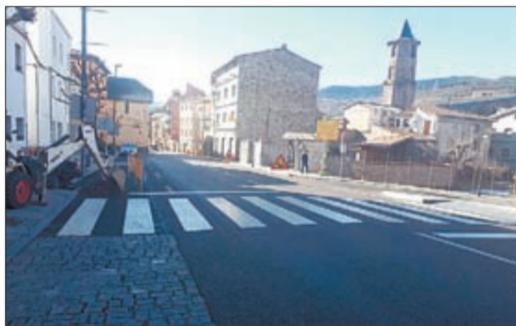
FOTO: N. Castells / Durant la instal·lació del nou semàfor a Vilaller
