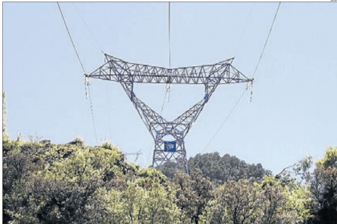
Línies d'alta tensió del Pirineu inclouen cables de fibra òptica per donar connexió a les hidroelèctriques.
