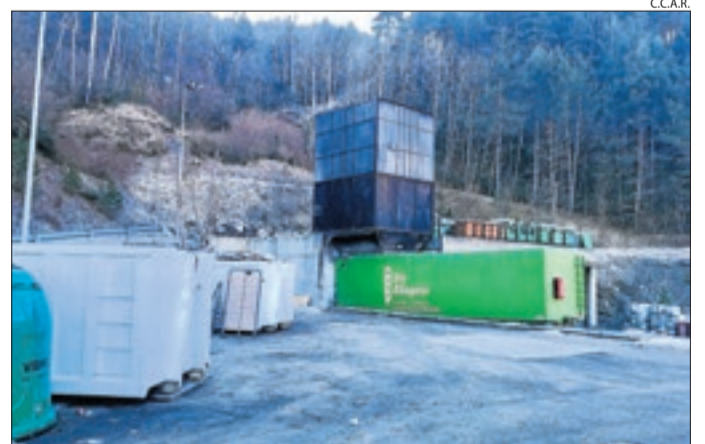
Les instal·lacions de la deixalleria de l'Alta Ribagorça.
