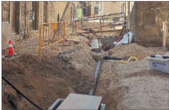
FOTO: Aj. Solsona / Els treballs de remodelació del carrer Sant Miquel
