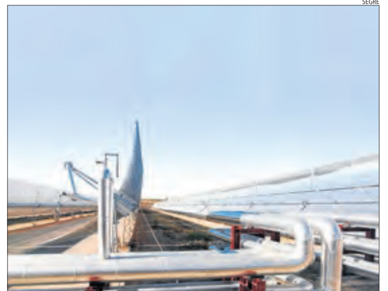
Panells solars d'una planta a les Garrigues.
