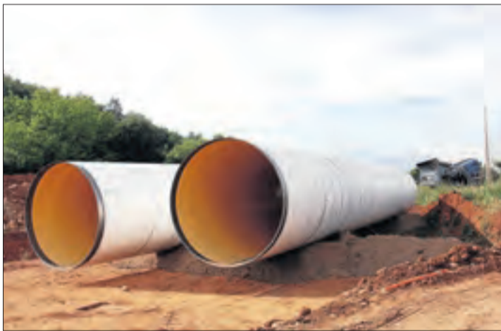
Imatge d'arxiu de les obres d'ampliació del regadiu.
