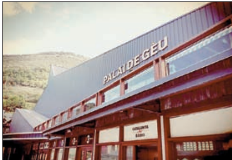
FOTO: Aj. Vielha / Façana del Palau de Gel que ha d'acollir la pista
