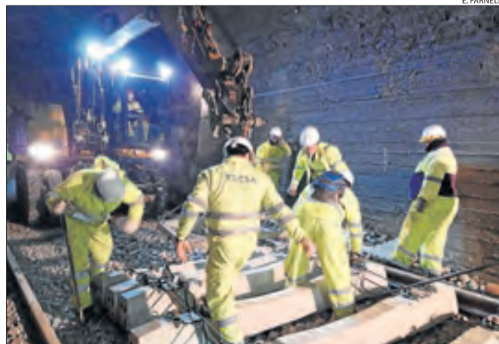
Imatge dels treballs en un túnel de la línia al gener.
