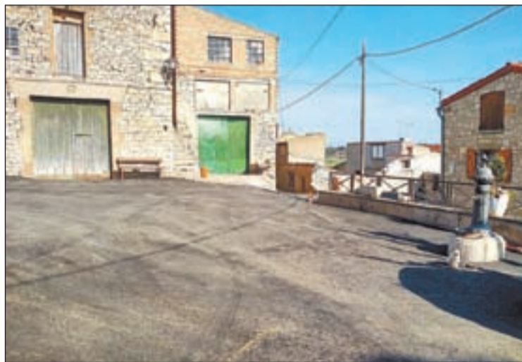
FOTO: Paeria de Cervera / Imatge de la plaça de Castellnou remodelada
