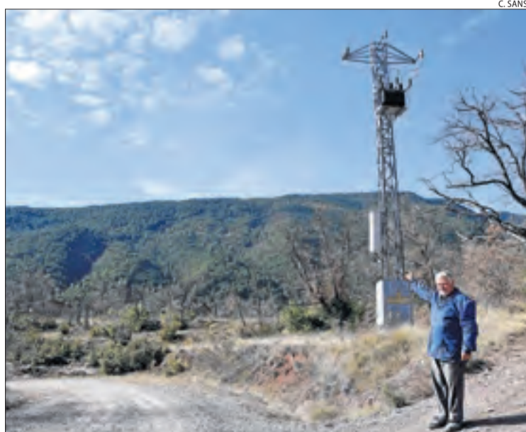
Una de les torres de la línia elèctrica inacabada.
