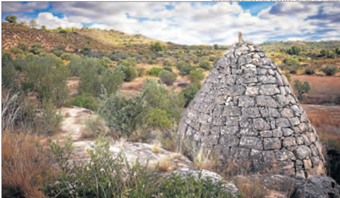
Una de les construccions de pedra seca que es poden trobar a Torrebesses.
