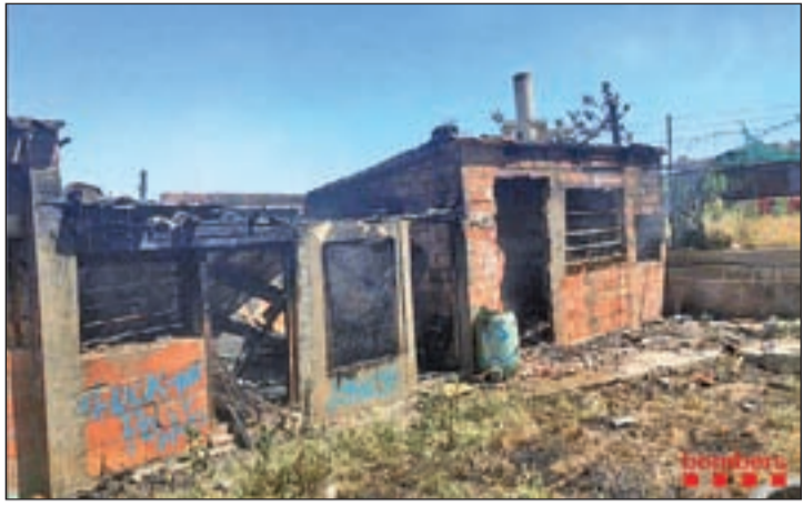
FOTO: Bombers / Estat en el que va quedar la cabana afectada pel foc
