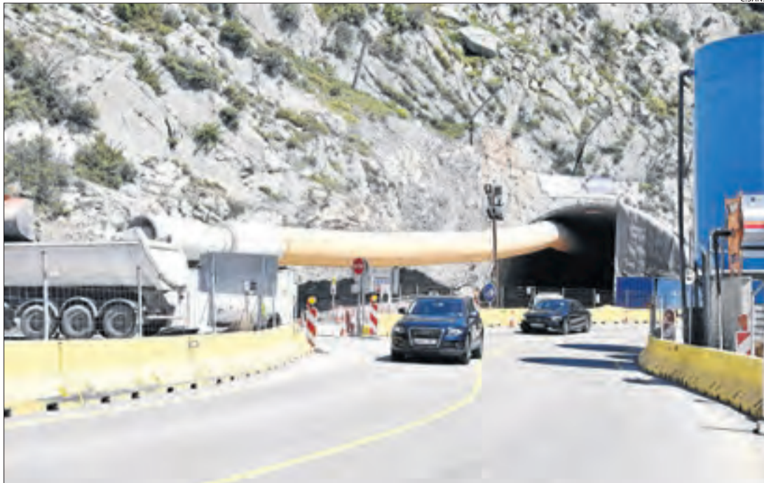
Imatge de les obres d'excavació de runa del túnel de Tres Ponts, a la carretera C-14.
