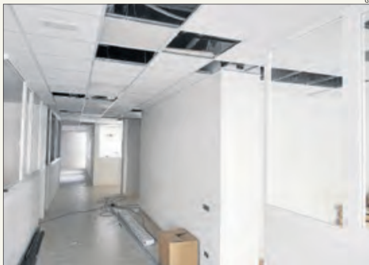
Obres de condicionament del centre a Tremp.
