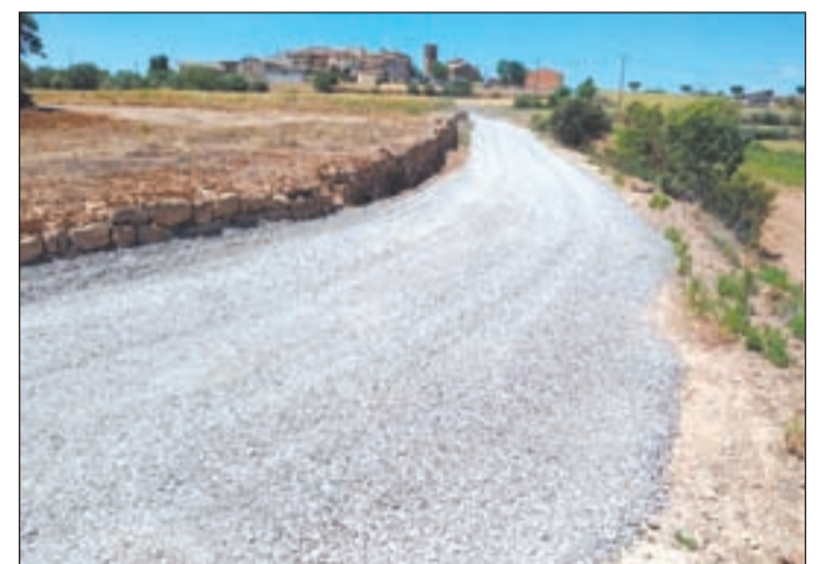
FOTO: Aj. Agramunt / Estat actual dels camins arreglats per les obres
