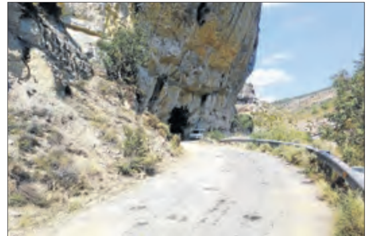
La carretera local va quedar oberta ahir a la tarda.
