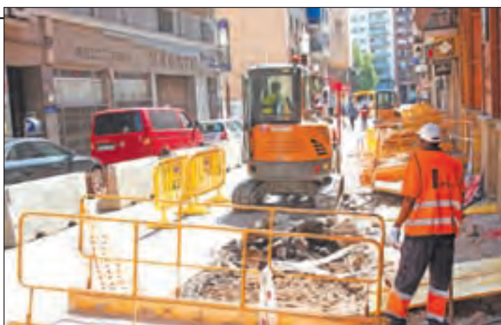
FOTO: Tony Alcántara / Las obras provocan retenciones de tráfico
