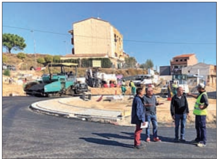
FOTO: Aj.Alcarràs / L'alcalde visità ahir l'estat de les obres
