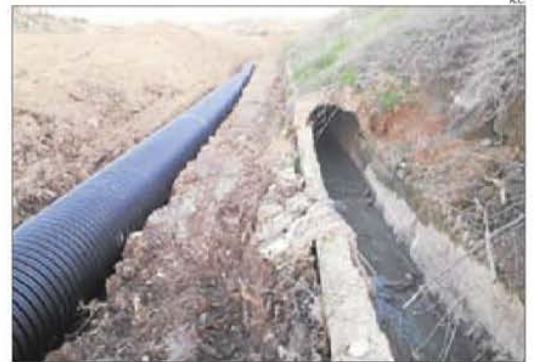
Col·lector a Castellldans ■ Castellldans ha iniciat aquesta setmana les obres de renovació del col·lector d'aigües residuals, que costarà 80.000 euros i que ara transcorre a cel obert.
