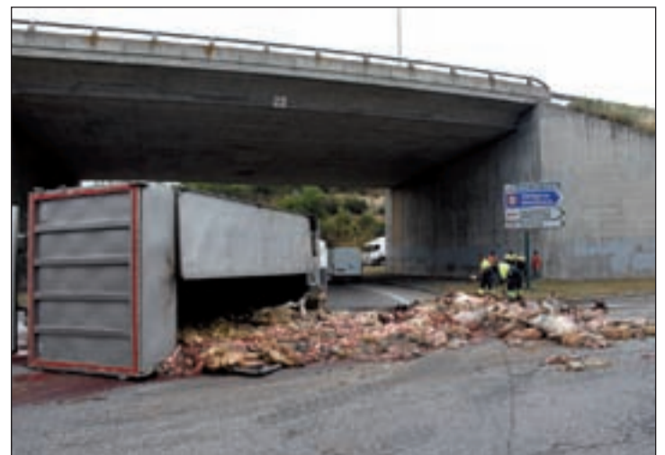
FOTO: Núria García / Estat en què va quedar el camió i la seva càrrega
