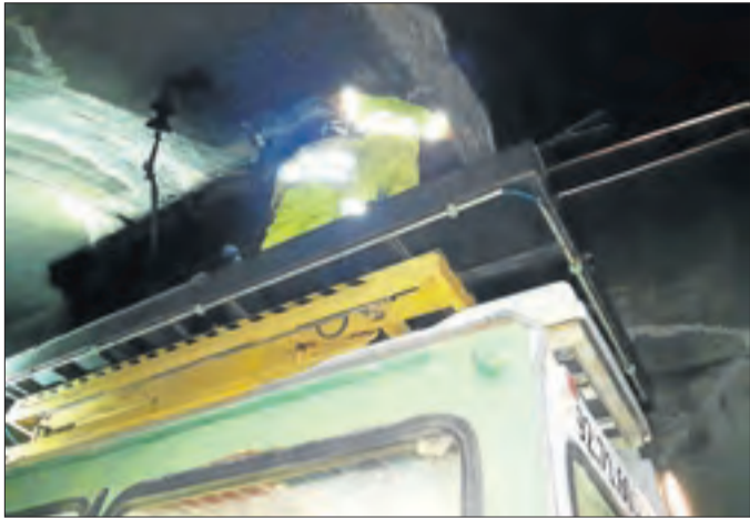
Operaris treballant després de la incidència entre Lleida i Raimat.
