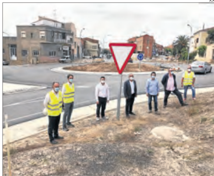
Gavín (tercer dreta) va visitar ahir les obres de la rotonda d'Alcarràs.
