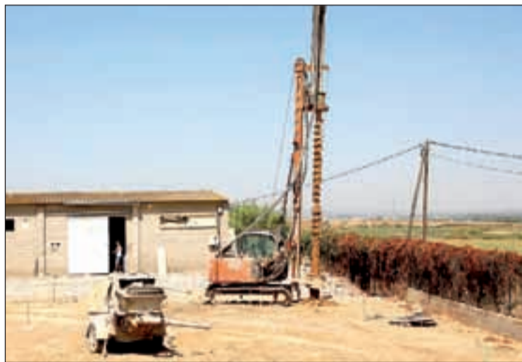
FOTO: Jordi Pascual / Les obres comencen amb els treballs de pilotatge
