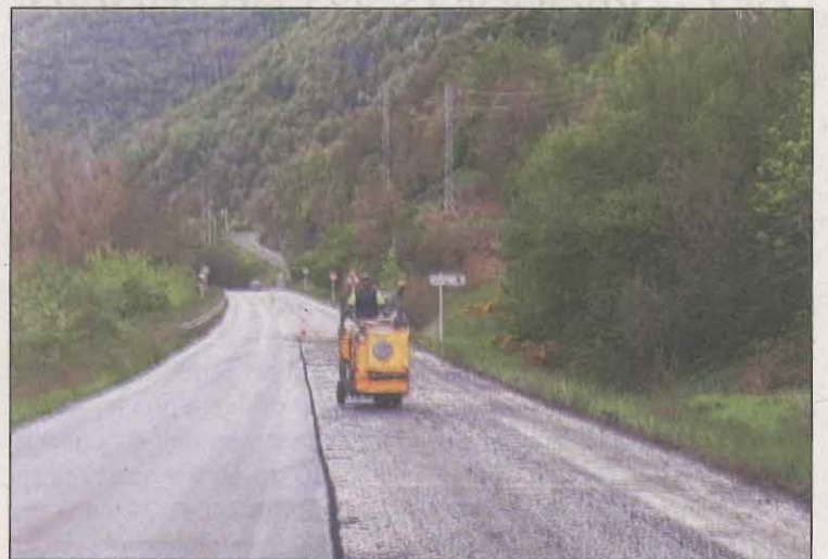
FOTO: N.C. / Les obres no obliguen a tallar la circulació
