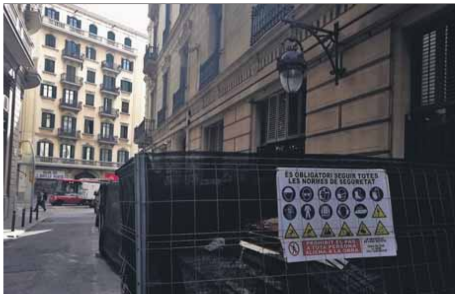
Una tanca situada al carrer Tomàs de Mieres, en un dels laterals de la prefectura, protegeix el material de runa que estan generant els treballs de reforma de la comissaria ■ J.P.F.
