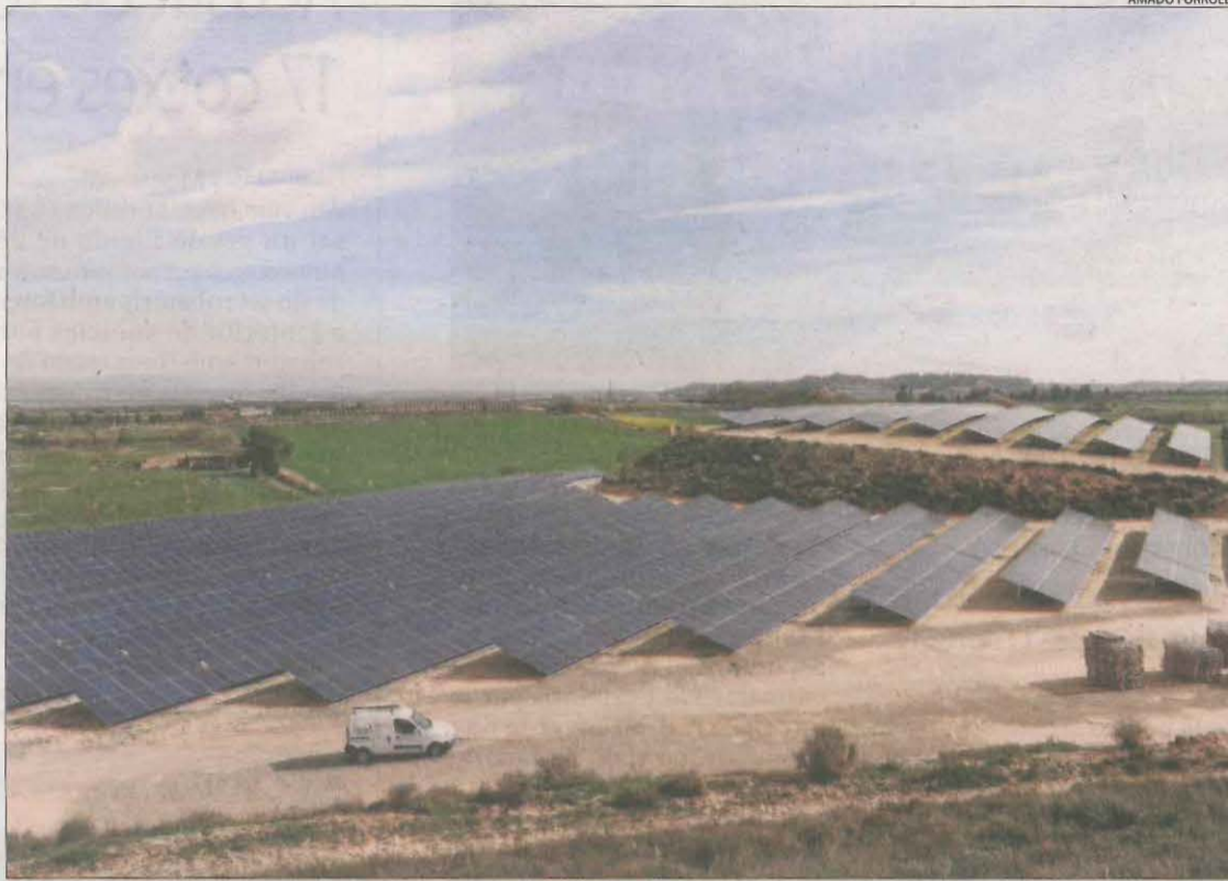
Panells solars desplecats al terme municipal d'Almacelles.
